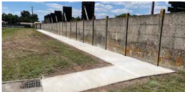
Réalisation voie PMR pas de tir à l'arc extérieur stade camblanes.
