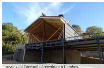
Travaux de l'accueil périscolaire à Cambes
